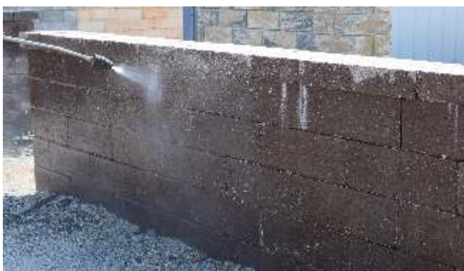
felület öblítése nagynyomású mosóval
