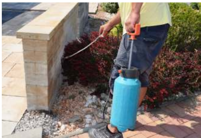
a termék felhordása kerti permetezővel
